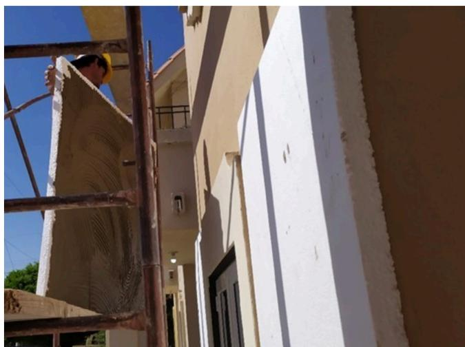
Colocación de capa continua de mortero adhesivo
